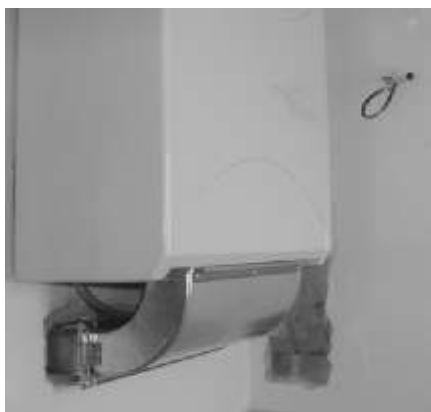
Вид с соседнего помещения
